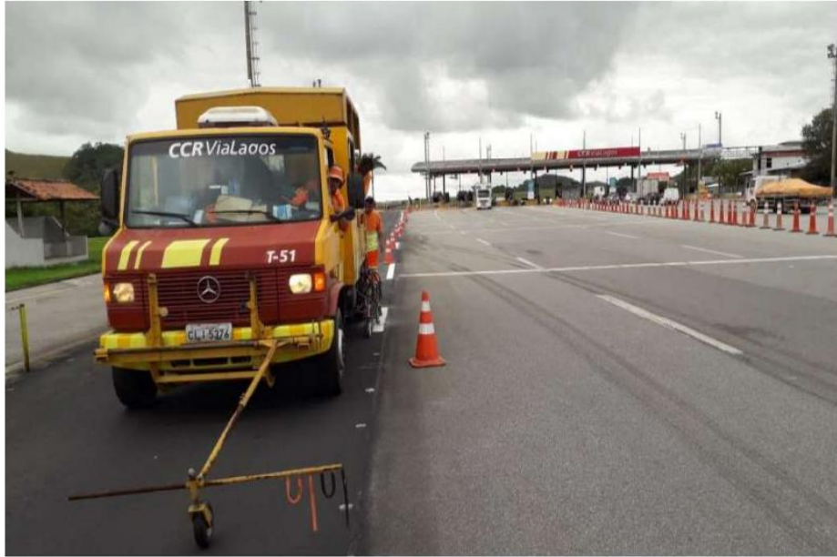
FOTO 01 - Pintura de Faixas - Km 21+500 Sul
