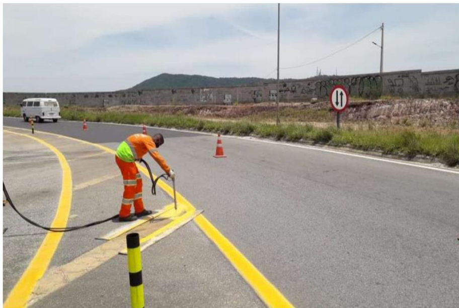
FOTO 04 – Pintura de Faixas – Km 56+800 Norte [2]
