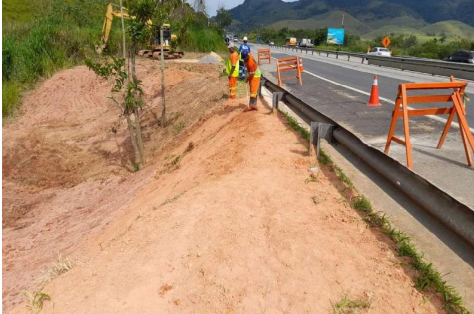
FOTO 11 - Ampliação Bueiro - Km 11+220
