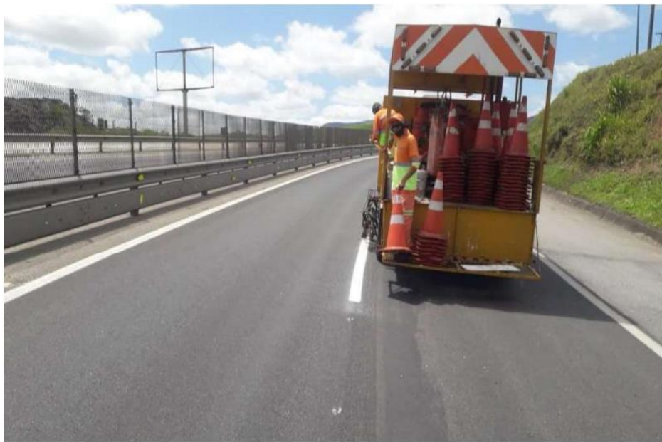
FOTO 02 - Pintura de Faixas - Km 8+400 Norte
