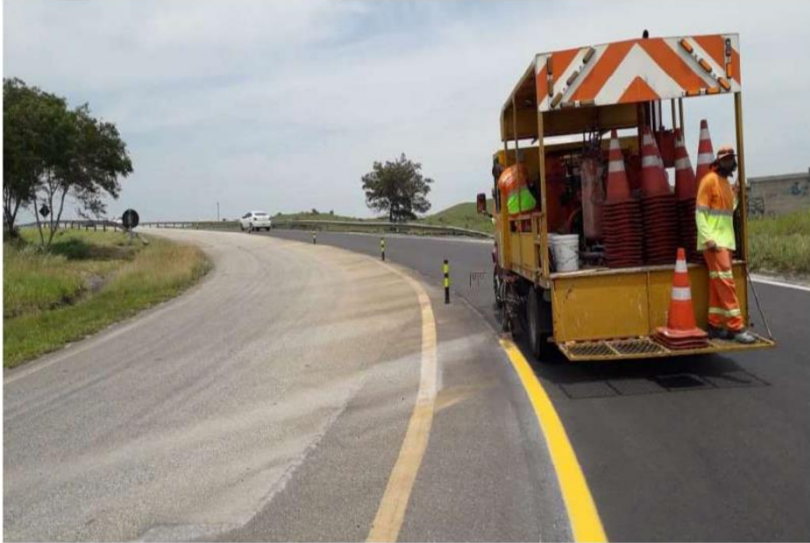
FOTO 03 – Pintura de Faixas – Km 56+800 Norte [1]
