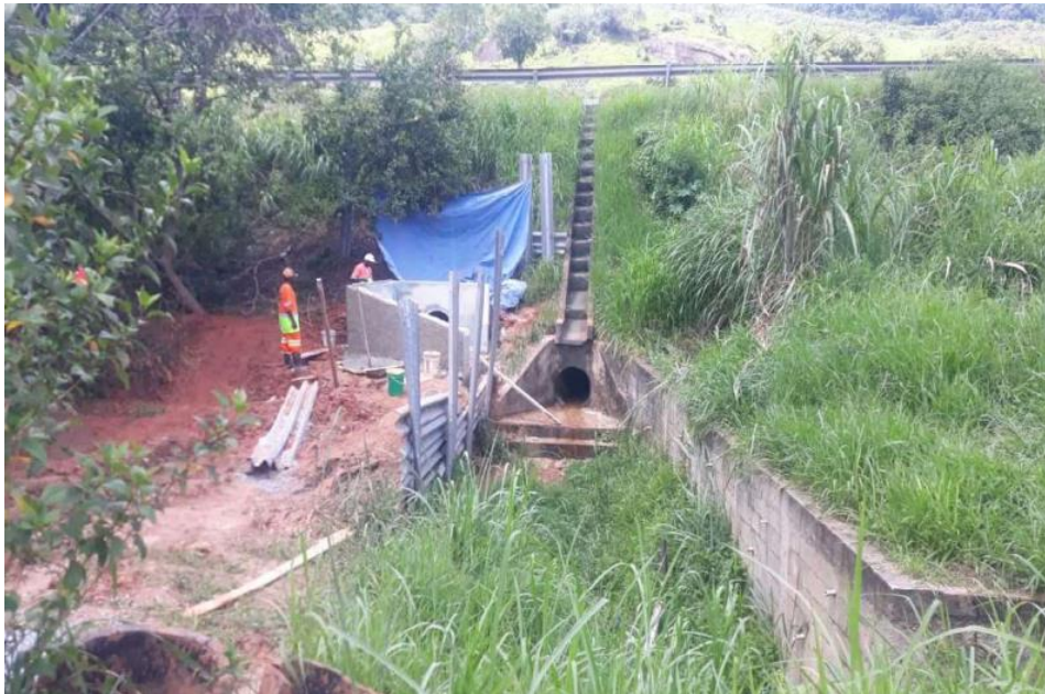
FOTO 12 - Ampliação Bueiro - Km 14+220
