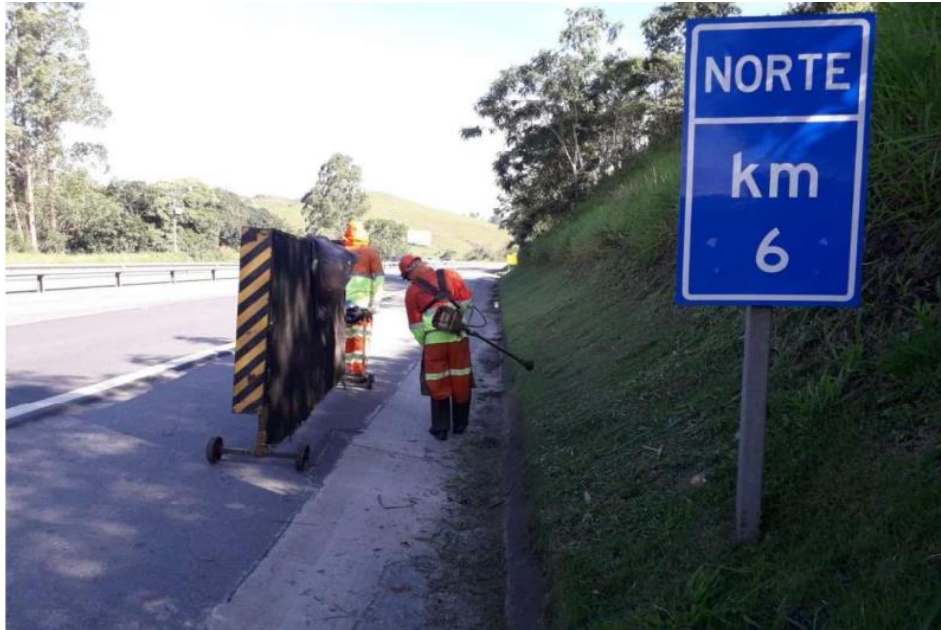
FOTO 07 – Roçada Manual - Km 6+000 Norte
